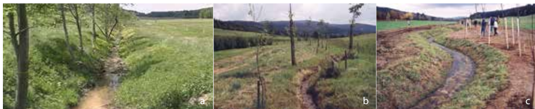
Obr. 1. Koryto potoka Borová u Borové: a) před revitalizací (foto V. Matoušek), b) revitalizační koryto 1. etapy, c) jeden z dílčích úseků druhé etapy revitalizace (2001) při provádění
