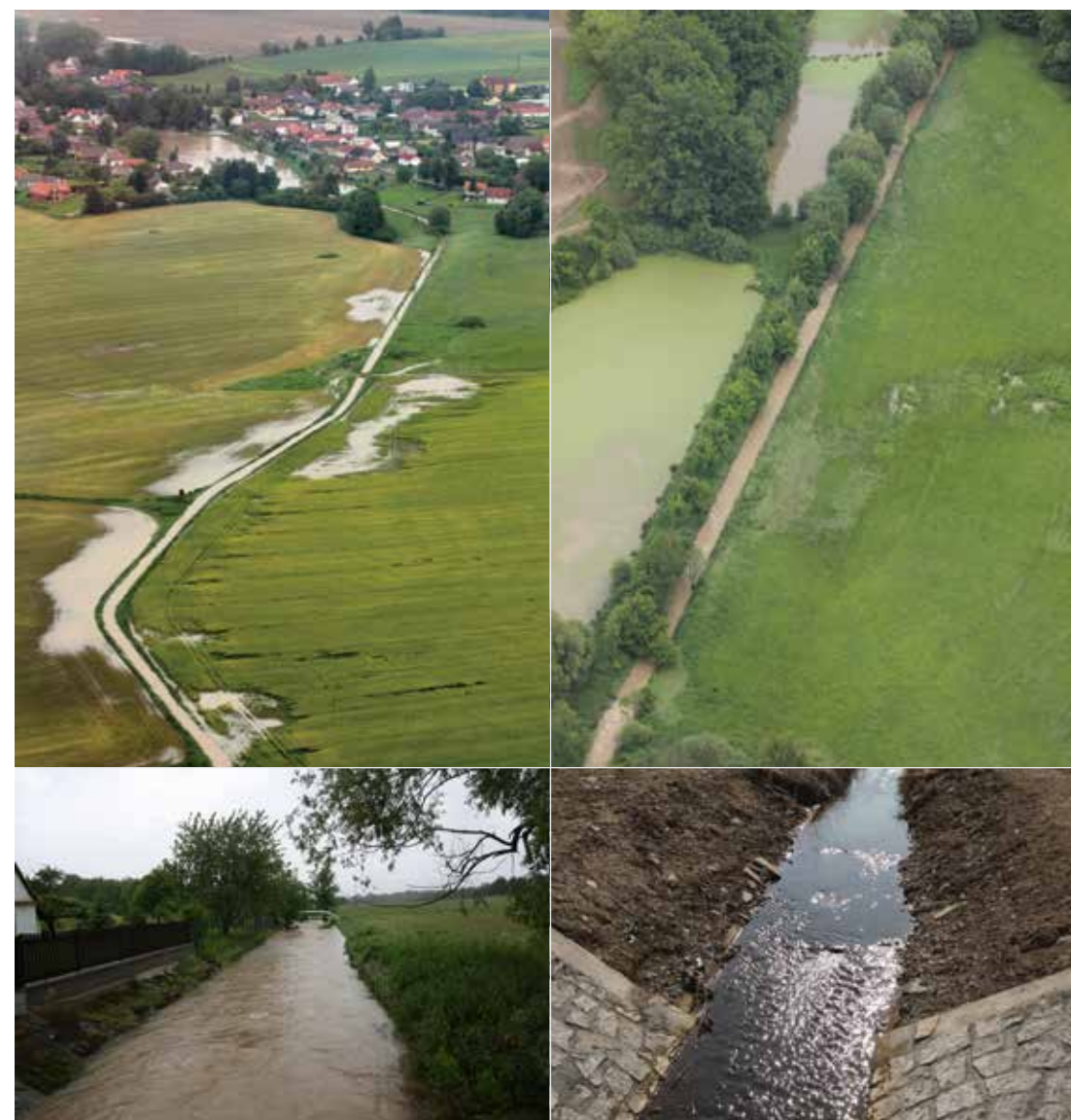
Obr. 8. Miletínský potok u obce Štěpánovice (10 km západně od Třeboně) s upraveným korytem při povodňové události v červnu 2013. Zrychlený odtok povodňové vlny umožňuje napřímené a zkapacitněné koryto. Vpravo dole: koryto za nízkého stavu vody.
