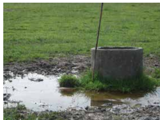
Obr. 4. Příklad projevů nefunkční drenáže (foto Z. Kulhavý)
